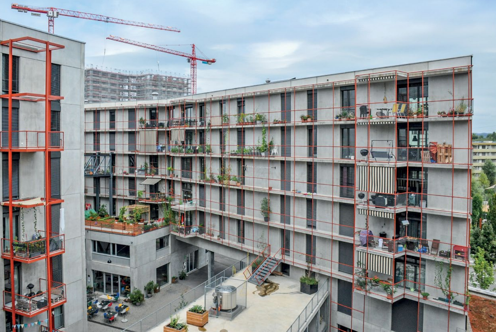
Abb. 48: Blick von Haus 6 auf Haus 5 (links) und Haus 4
