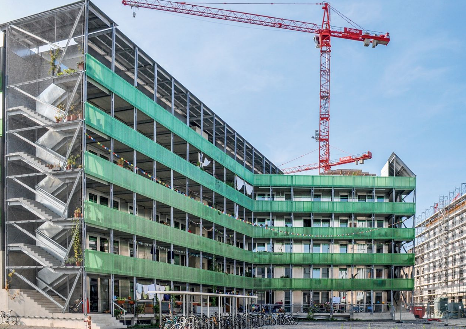
Abb. 70: StadtErle, Hof-Fassade mit sichtbarer Außenerschließung
