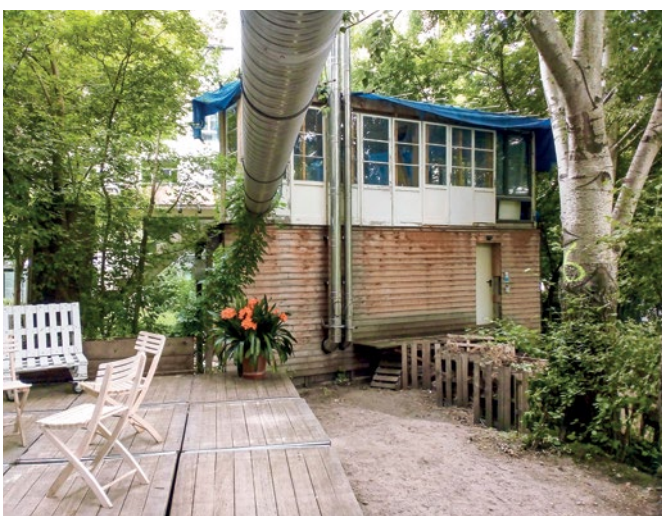
Abb. 12: Heizhaus und Gartenterrasse
