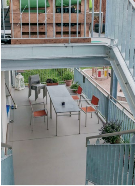
Abb. 61: Außenliegende zweite Erschließung
