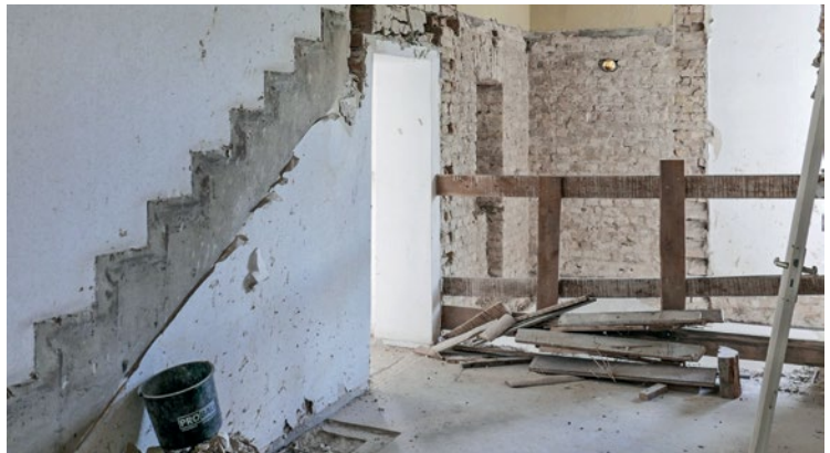
Abb. 83: Weitreichende Umbauarbeiten für ein neues Treppenhaus
