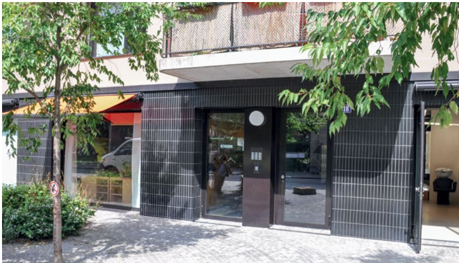
Abb. 35: Hauseingang und Gewerbeeingänge im EG
