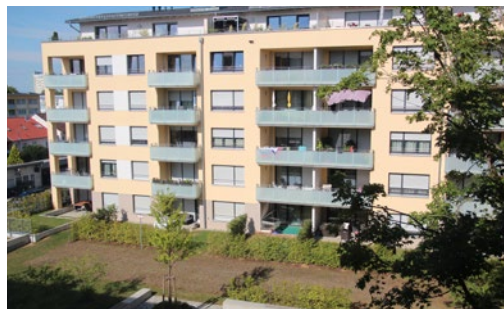
Zeilenbau mit Penthouse: Rot, Stuttgart
