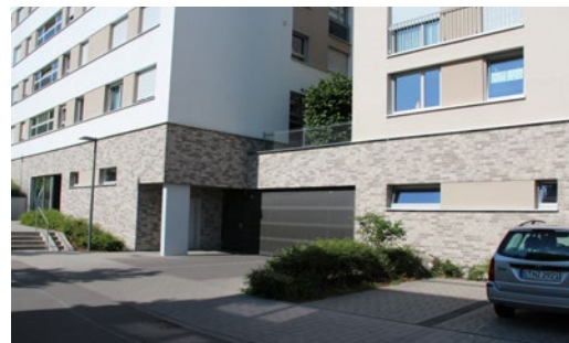
Straßenebene talseitig: Feuerbacher Balkon, Stuttgart
