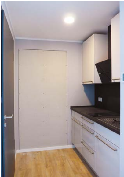
Abb. 4 Meschede: Sollbruchstelle für späteren Türeinbau zwischen zwei Einzelapartments [© BF Vario, Andreas Dalkowski]
