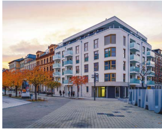
Abb. 38 Chemnitz: Außenbeziehung der im Erdgeschoss des Gebäudes angesiedelten Funktionen im Erdgeschossbereich zur Fußgängerzone [© Grundstücks- und Gebäudewirtschafts-Gesellschaft m.b.H.]
