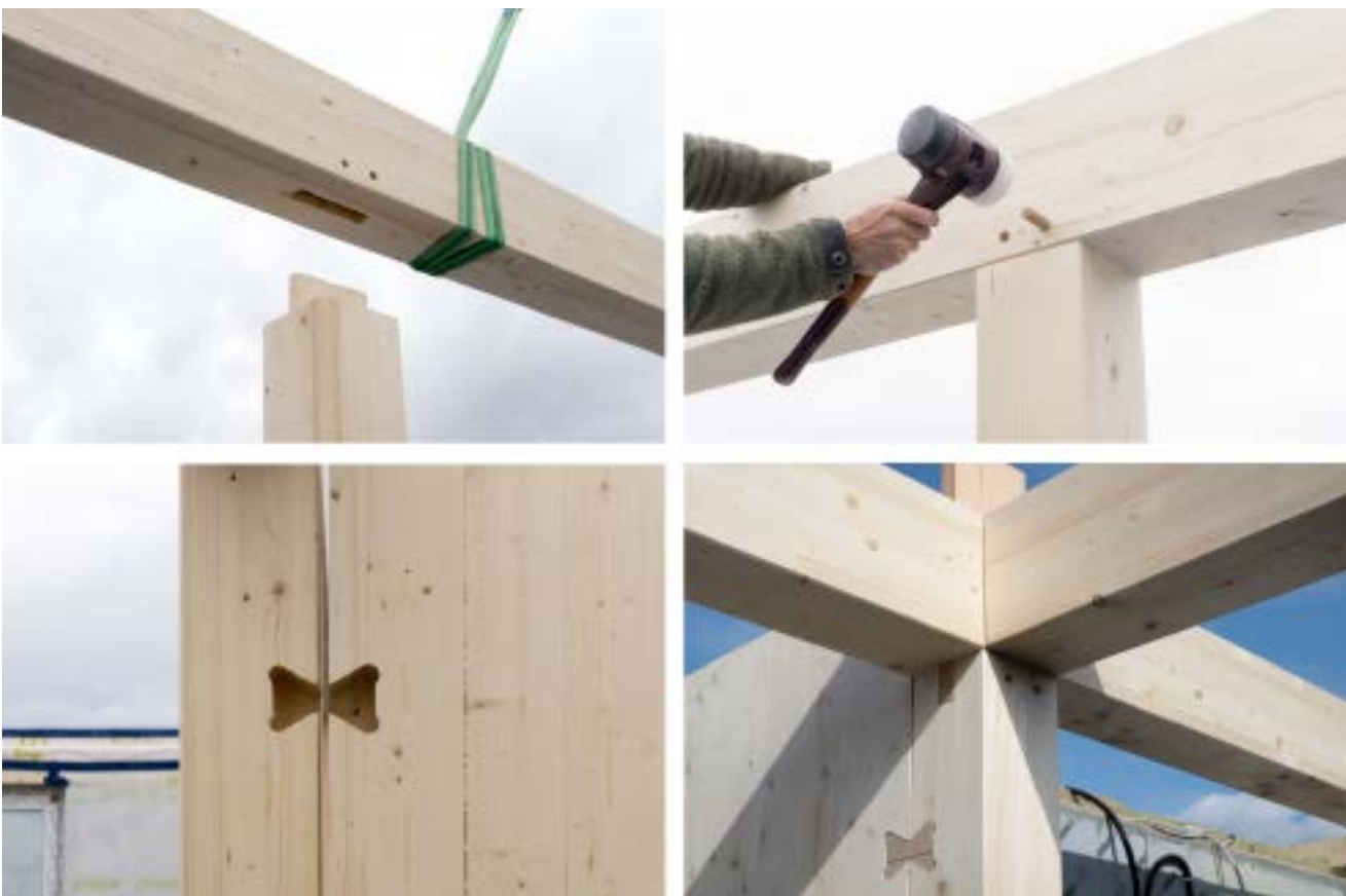
Abb. 13 Heidelberg: Bei der Fügung der Holzbauteile wird, soweit möglich, auf Metallteile verzichtet. [© DGJ Architektur GmbH]
