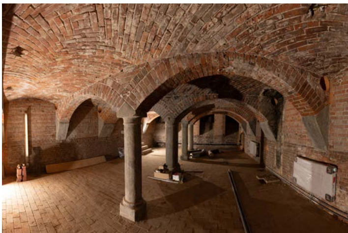
Abb. 125 Der alte Brauereikeller unter Haus 4 soll extern verpachtet und gastronomisch genutzt werden. Auch Studierende können diesen Bereich für Veranstaltungen mieten. [© BBSR/BILDKRAFTWERK/Peter-Paul Weiler]
