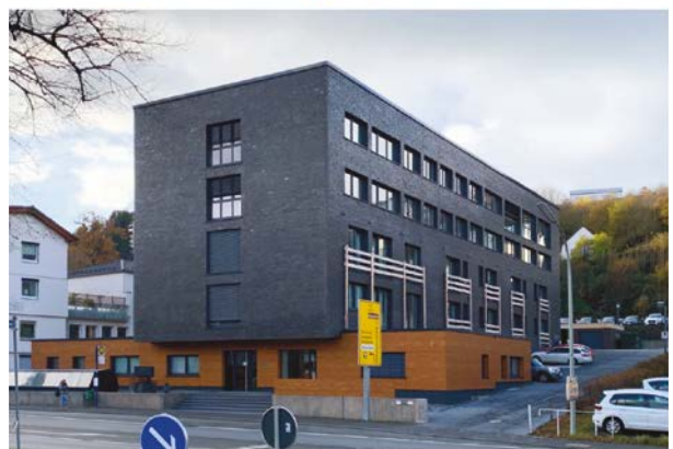
Abb. 167 Ansicht vor und nach der Sanierung [© TUD, Fachgebiet Entwerfen und Baukonstruktion]
