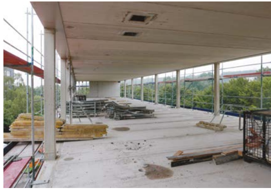
Abb. 30 Bochum: Stahlbeton-Skelettbau mit Fertigelementen: Trotz großer Spannweite ist keine weitere Stützenreihe erforderlich. [© Ingo Wiederoder/BF Vario]
