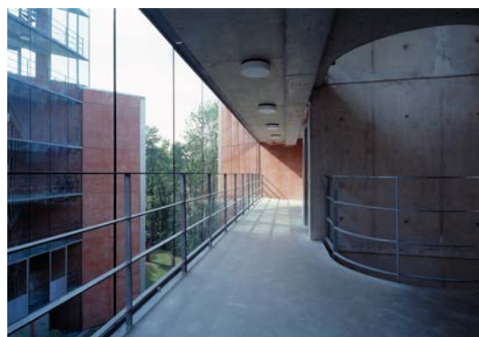
Abb. 206 Vollverglastes Treppenpodest [© Tomas Riehle/ ACMS Architekten GmbH]
