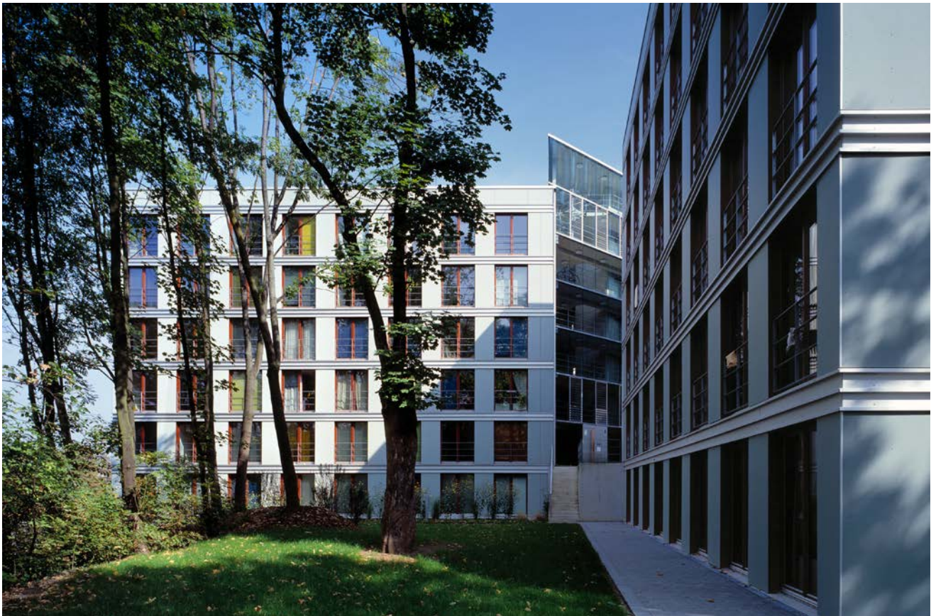
Abb. 75 Wuppertal-Burse: Revitalisierung des Studentenwohnheims von 1961/77 mit neuen Fassadenelementen [© Thomas Riehle].
