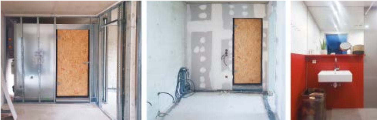
Abb. 23 Wuppertal-Elberfeld: Die Stahl-Fertignasszellen werden mit Gipskartonplatten verkleidet – innen sind sie bereits bei Lieferung vollständig ausgebaut. [© Prime Value Invest GmbH]
