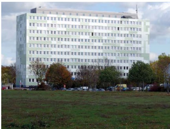
Abb. 66 Erfurt: Ehemalige Zahnklinik nach der Sanierung [© Günter Löhnert/BF Vario]
