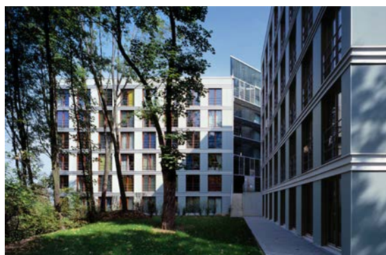
Abb. 205 Sanierte Fassade mit großen Fenstern [© Tomas Riehle/ ACMS Architekten GmbH]
