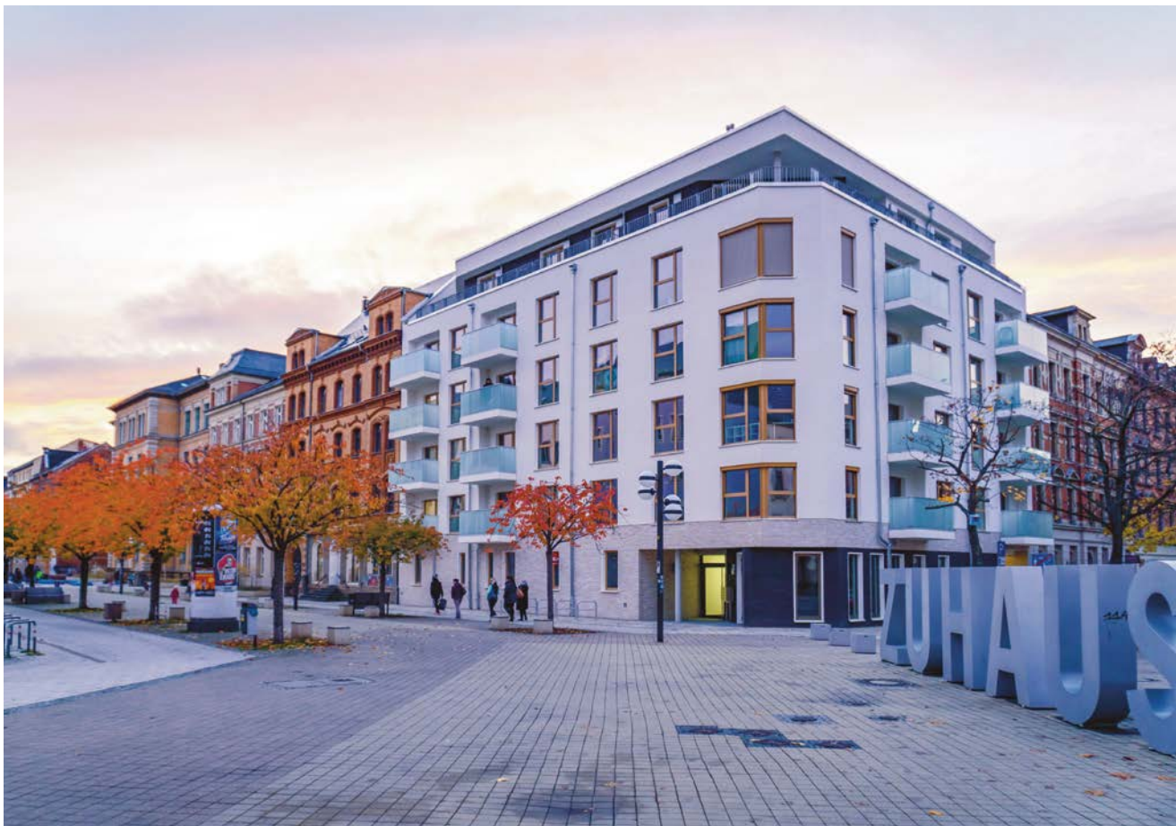
Abb. 103 Brühl 65 in Chemnitz [© Grundstücks- und Gebäudewirtschafts-Gesellschaft Chemnitz]
