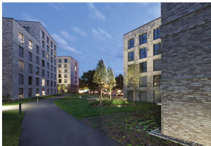
Abb. 189 Innenhof der Wohnanlage [© Anke Müllerklein/APB. Grossmann-Hensel Schneider Andresen Architekten und Stadtplaner PartGmbH]
