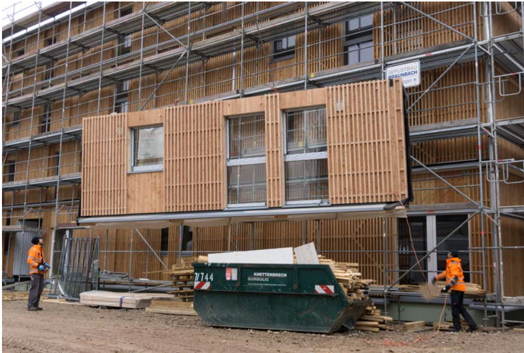
Abb. 14 Heidelberg: Die robuste Holzbekleidung ist bereits an den vorgefertigten Fassadenelementen montiert. [© DGJ Architektur GmbH]
