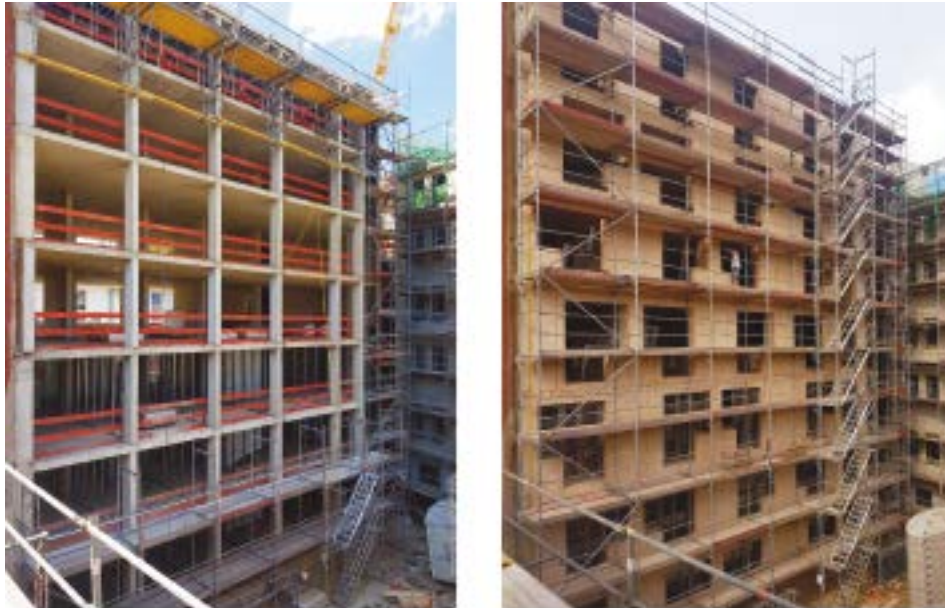
Abb. 15 Wuppertal-Elberfeld: Links das Stahlbetonskelett, rechts die mit vorgefertigten Holztafeln geschlossene Fassade [© Prime Value Invest GmbH]
