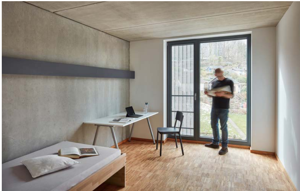
Abb. 12 Wuppertal-Griffenberg: Durch einen Medienkanal vor der Betonfertigteilwand konnten in Wuppertal mit einer auch gestalterisch überzeugenden Lösung Gewerkeschnittstellen reduziert werden. [© Sigurd Steinprinz/ACMS Architekten GmbH]
