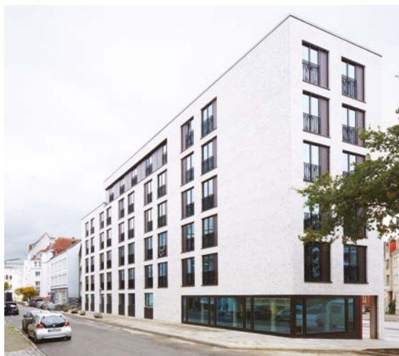
Abb. 192 Gebäudeseite zur ruhigeren Wohnstraße [© Ralf Buscher/Heider Zeichardt Architekten]
