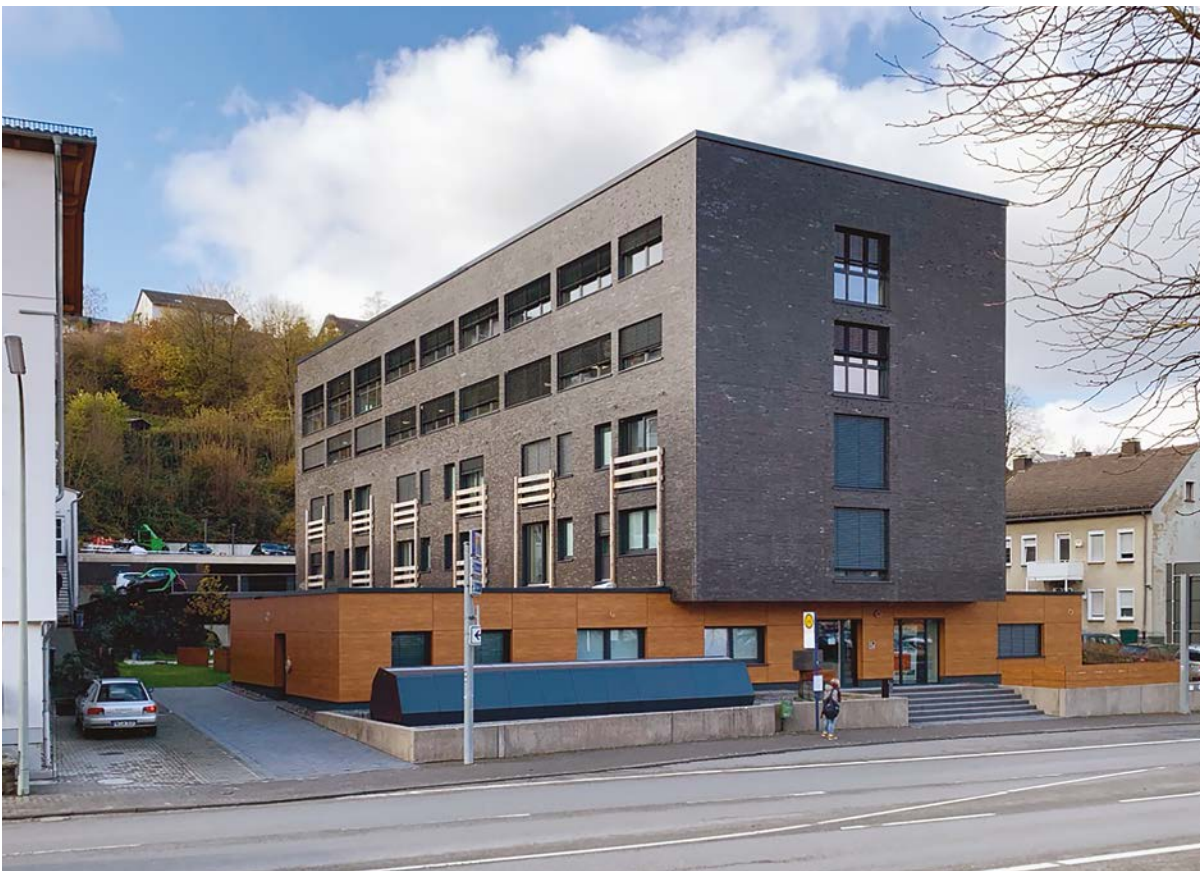
Abb. 166 Ansicht von der Straße [© TUD, Fachgebiet Entwerfen und Baukonstruktion]
