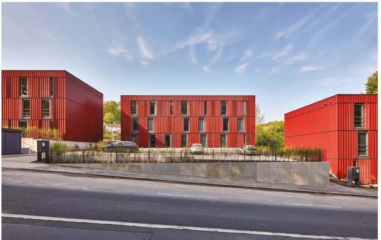
Abb. 184 Straßenansicht der dreigeschossigen Blöcke am Hang [© Sigurd Steinprinz, Düsseldorf/ACMS Architekten GmbH]
