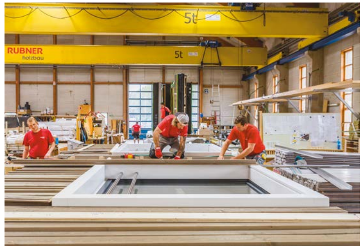
Abb. 96 Vorfertigung der Fassade im Werk [© Rubner Holzbau, Ober-Grafendorf]
