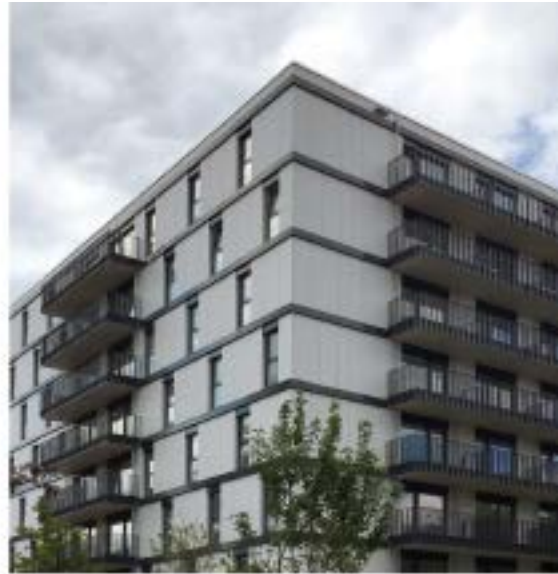
Abb. 16 Berlin-Marzahn: Die Fassade aus Holztafelelementen (links) wurde nachträglich mit Faserzementplatten verkleidet (rechts). [© Günter Löhnert/BF Vario]
