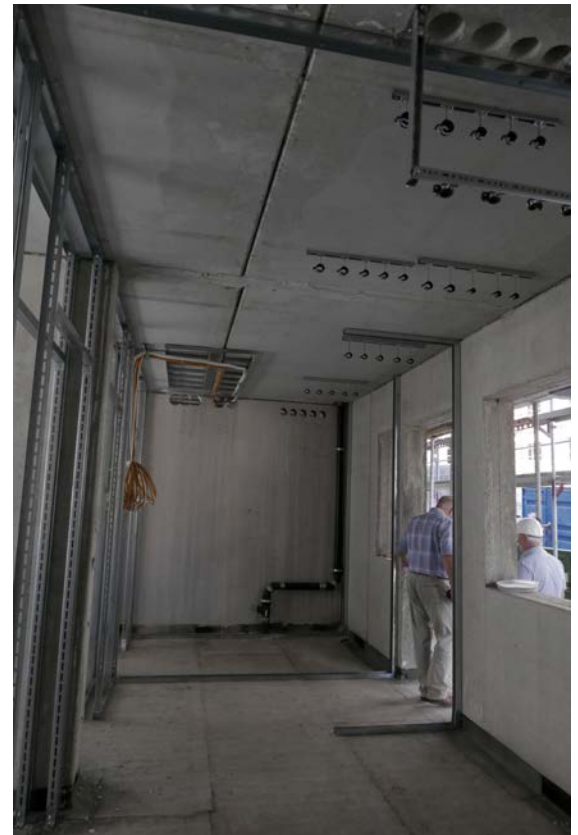
Abb. 159 Die Bauweise mit überwiegend Fertigteilen für Wände und Decken sorgte für eine rasche Erstellung des Rohbaus. [© Ingo Wiederoder/BF Vario]
