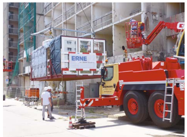
Abb. 129 Das angelieferte Raummodul ist zum Einbau vorbereitet. [© Andreas Dalkowski/BF Vario]
