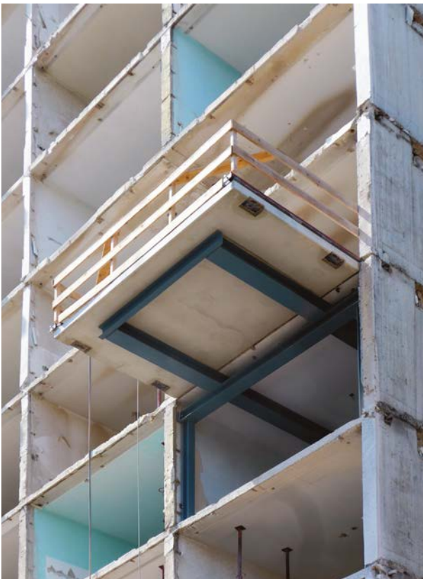
Abb. 131 Auf Rohbau rückgebaute Strukturen mit Wohnraumerweiterungsplatte. Die Stahlkonstruktion wurde nur temporär für den Einbau des Probemoduls benötigt, später werden die Wohnraumerweiterungen separat gegründet. [© Andreas Dalkowski/BF Vario]
