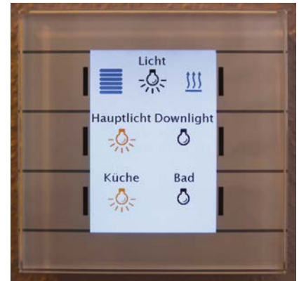
Abb. 35 Meschede: Mit einem Schalttafelau lässt sich das Licht in der gesamten Wohnung managen. [© Andreas Dalkowski/BF Vario]
