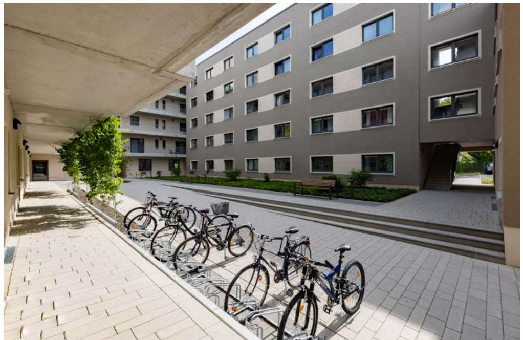
Abb. 156 Alle Eingänge zu den Treppenhäusern liegen zentral zum kommunikativ angelegten offenen Innenhof. [© BBSR/BILDKRAFTWERK/Peter-Paul Weiler]
