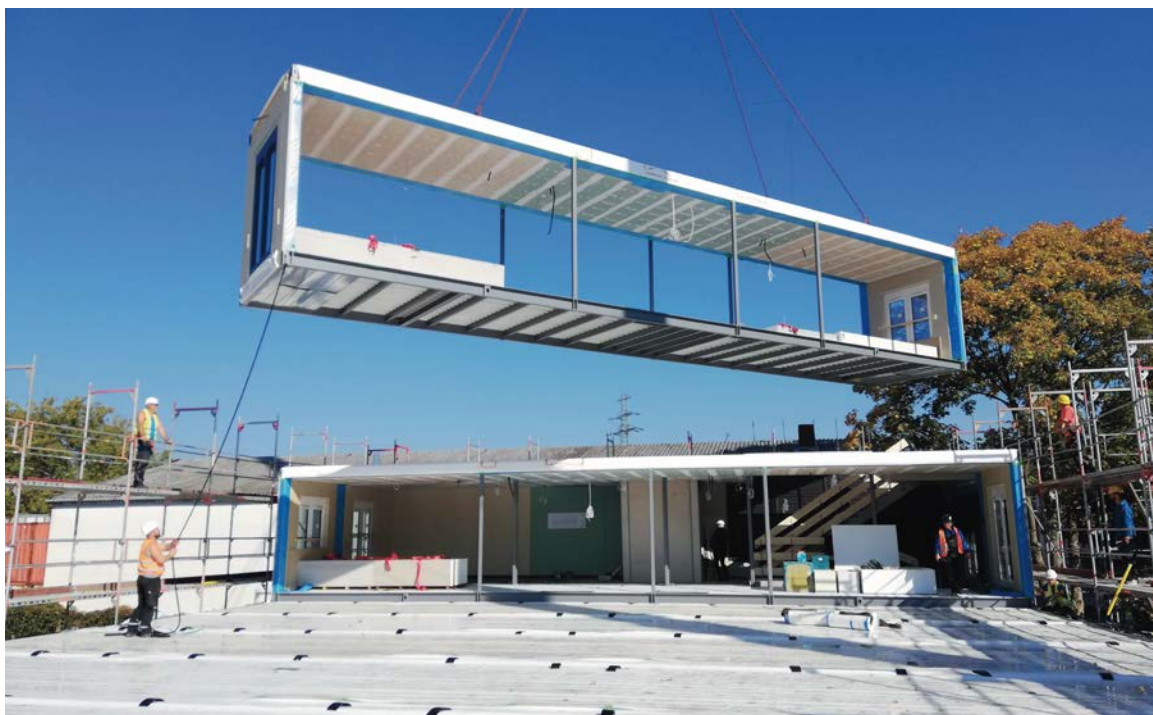
Abb. 143 Die vorgefertigten Raummodule reichen über die gesamte Gebäudetiefe. [© Christina Hagenhoff/BFVario]
