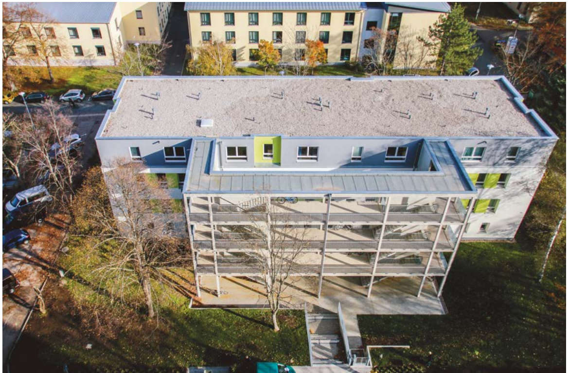
Abb. 113 Das ehemalige Blutspendezentrum von oben [© Friedrich May/BF Vario]
