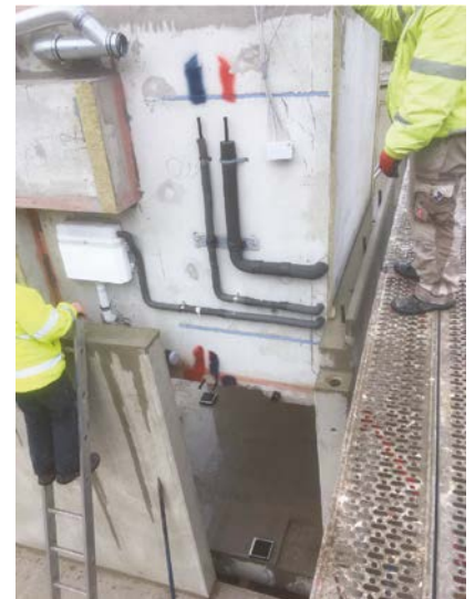
Abb. 22 Hamburg-Harburg: Beim Platzieren der Beton-Fertignasszellen zwischen den Stahlbetonwänden ist hohe Sorgfalt gefragt. [© Andreas Hartmann/TU Berlin]
