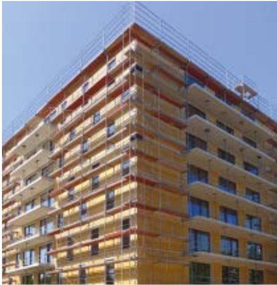
Abb. 16 Berlin-Marzahn: Die Fassade aus Holztafelelementen (links) wurde nachträglich mit Faserzementplatten verkleidet (rechts). [© Günter Löhnert/BF Vario]
