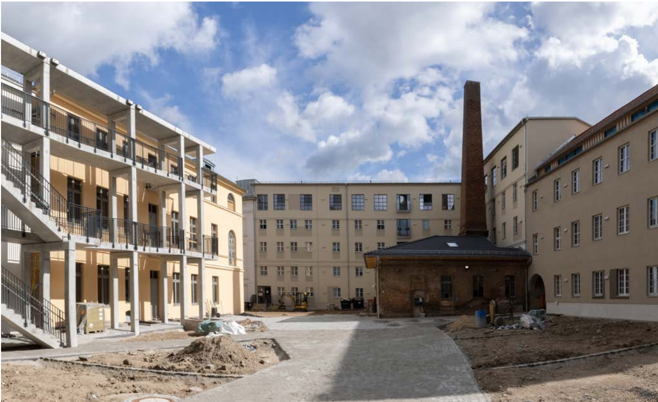
Abb. 74 Frankfurt (Oder): Das Industrieensemble wurde durch einzelne Gebäude ergänzt [© BBSR/BILDKRAFTWERK/Peter-Paul Weiler]
