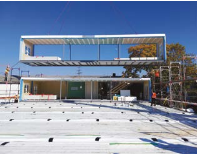
Abb. 25 Hamburg-Steilshoop: Durch die gewählte Modulbauweise konnte das Modellprojekt in kürzester Zeit errichtet werden. [© Christina Hagenhoff/BF Vario]
