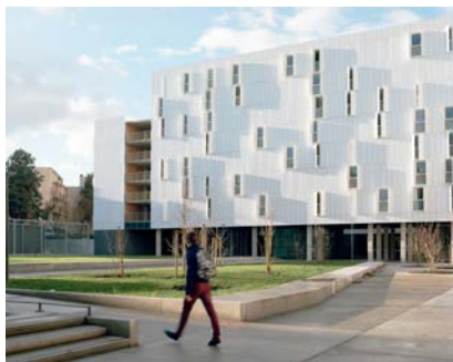
Abb. 214 Ansicht vom Campus aus [© Antoine Séguin/PPA Architectures]
