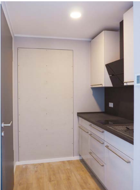
Abb. 170 Solldurchbruch im Flur/Küchenbereich [© Günter Löhnert/BF Vario]
