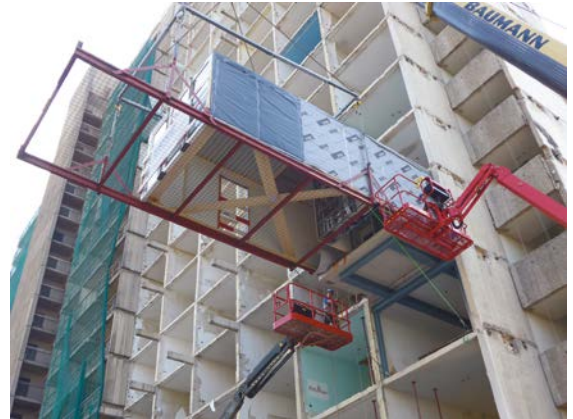
Abb. 132 Einschub des Probe-Raummoduls mittels einer Hilfskonstruktion aus Stahlträgern [© Andreas Dalkowski/BF Vario]
