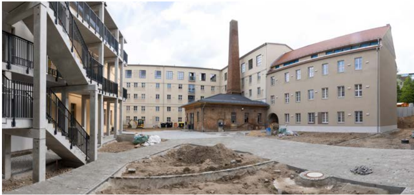
Abb. 12 Die Häuser zeichnen sich durch unterschiedlich helle Putzfarben und verschiedene Geschosshöhen aus. [© BBSR/BILDKRAFTWERK/Peter-Paul Weiler]
