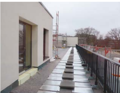
Abb. 26 Hamburg-Steilshoop: Das Geländer der Dachterrasse kann nicht ohne Weiteres an den Modulen befestigt werden. In Hamburg erfolgt die Sicherung per Auflast. [© Günter Löhnert/BF Vario]
