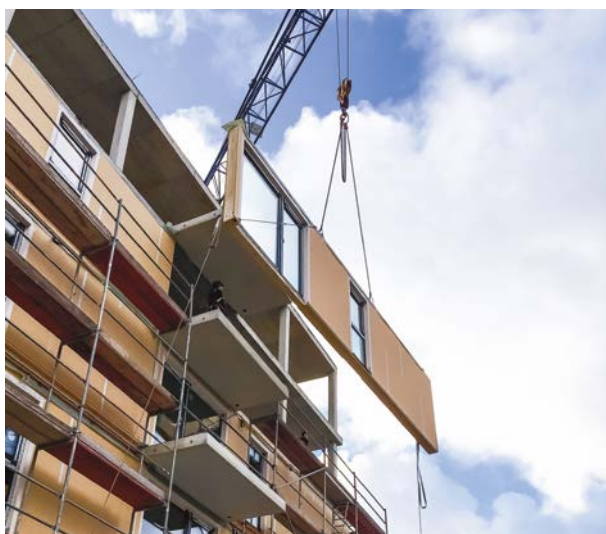
Abb. 90 Einbau der vorgefertigten Außenwand-Montageelemente [© thoma architekten]
