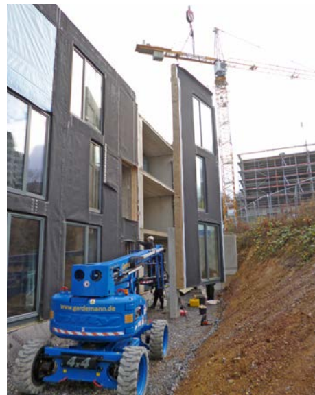
Abb. 18 Wuppertal-Griffenberg: Montage der haushohen Fassadenelemente [© ACMS Architekten]
