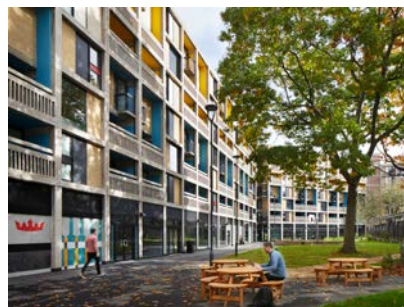
Abb. 222 Sanierter Bauabschnitt mit Laubengang [© Jack Hobhouse/Whittam Cox Architects]
