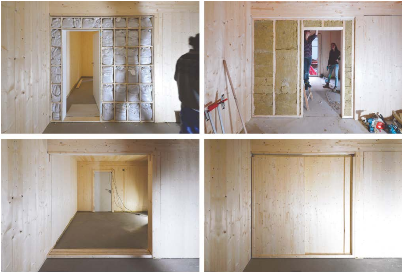
Abb. 7 Heidelberg: Verschiedene austauschbare Wandvariationen im Teststand [Quelle: DGJ Architektur GmbH]
