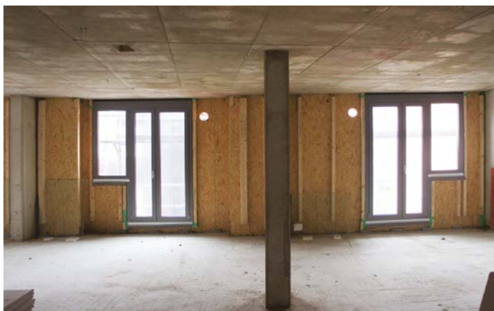
Abb. 176 Innenraumansicht Rohbau mit Fertigteilfassade und Öffnungen für die Entlüftung [© Friedrich May/BFVario]
