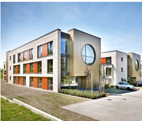
Abb. 195 Treppenhausfassaden mit großen runden Fenstern [© RSK Architekten]
