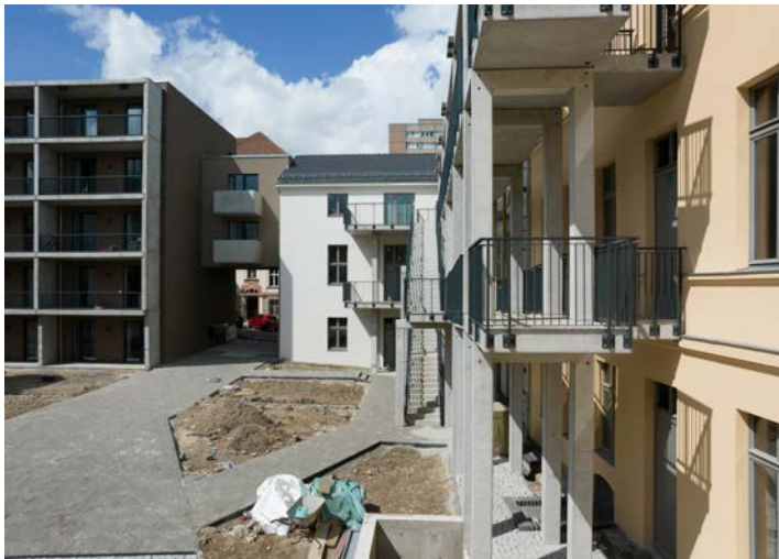
Abb. 124 Hofansicht nach Osten mit Blick auf die Neubaugängung (Haus 8). Rechts ist die vorgestellte Erschließung aus Betonfertigteilen zu erkennen. [© BBSR/BILDKRAFTWERK/Peter-Paul Weiler]
