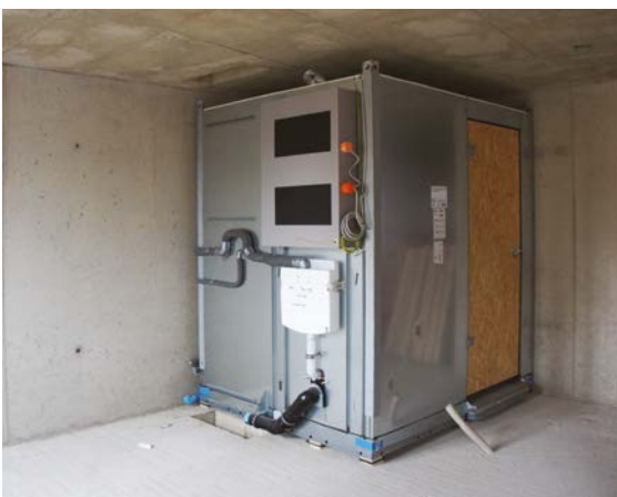
Abb. 175 Vorgefertigte Nasszelle mit Installationselementen [© Friedrich May/BFVario]
