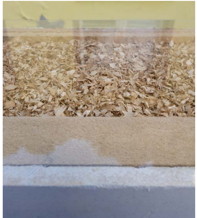
Abbildung 39: Wandquerschnitt Holzwand mit Naturfaserdämmung [Quelle: STÖBE. Die Agentur für Kommunikation GmbH]
