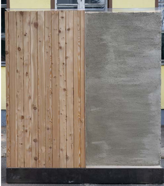
Abbildung 36: Musterwand Holz-Lehm-Haus [Quelle: STÖBE. Die Agentur für Kommunikation GmbH]
