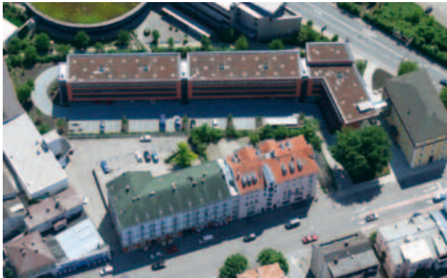
Hauptzollamt Rosenheim (Chief Custom Office Rosenheim): Urban Space Situation (Photo: Staatliches Bauamt Rosenheim, Schellmoser)
